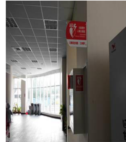
屏師校區游泳池一樓 大廳樓梯旁牆面
